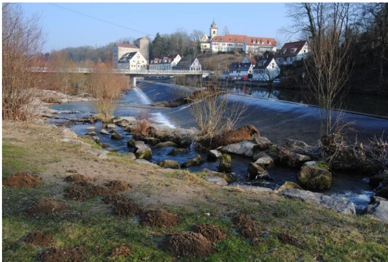
Abbildung 13.1: Streichwehr mit Fischwanderhilfe
