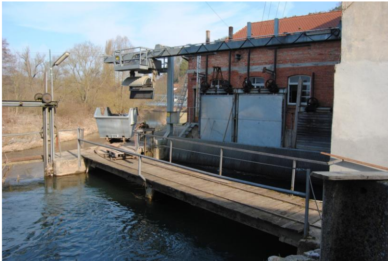
Abbildung 3.1: Kanaleinlauf zum Krafthaus mit Rechenreinigungsanlage
