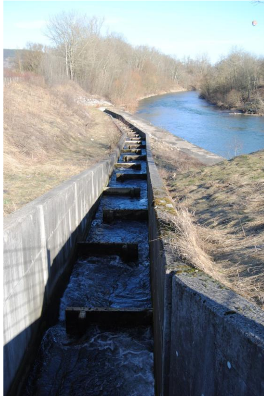
Abbildung 7.4: Beckenschlitzpass im Bereich nach dem Wehr
