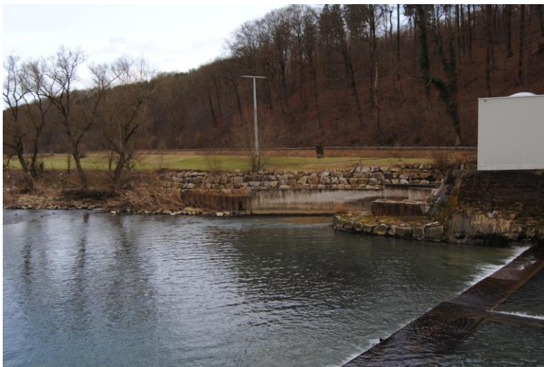
Abbildung 11.6: Der Fischpass ist zwischen der Mauer und den Natursteinen in der Bildmitte angelegt, links erkennt man den Auslauf
