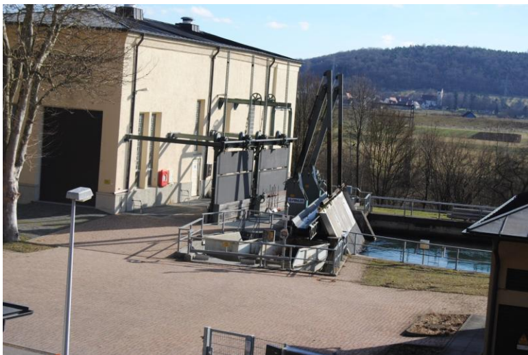
Abbildung 8.2: Rechenreinigungsanlage
