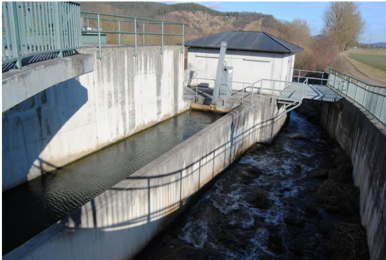
Abbildung 8.5: Restwasserkraftwerk mit Rechenanlage
