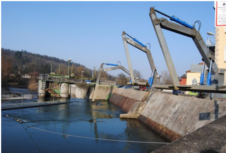
Abbildung 13.3: Automatische Rechenanlage mit drei Rechen
