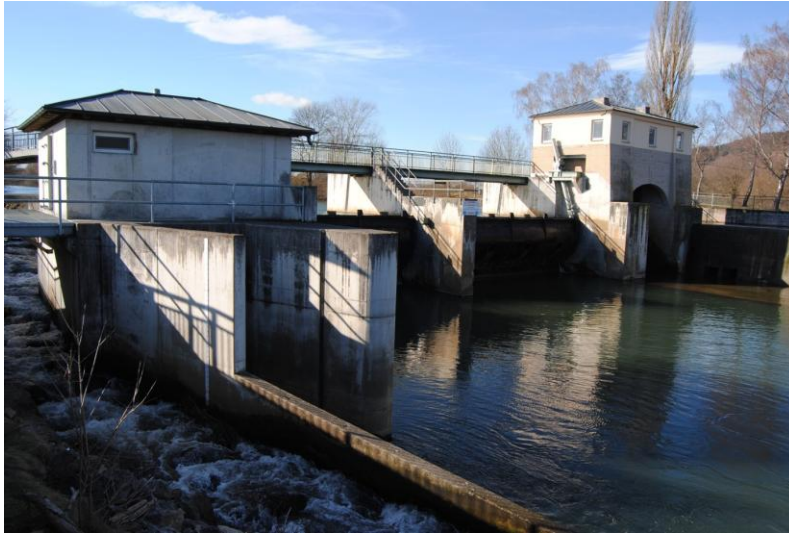
Abbildung 8.3: Wehranlage mit zweigliedrigem Klappenwehr
