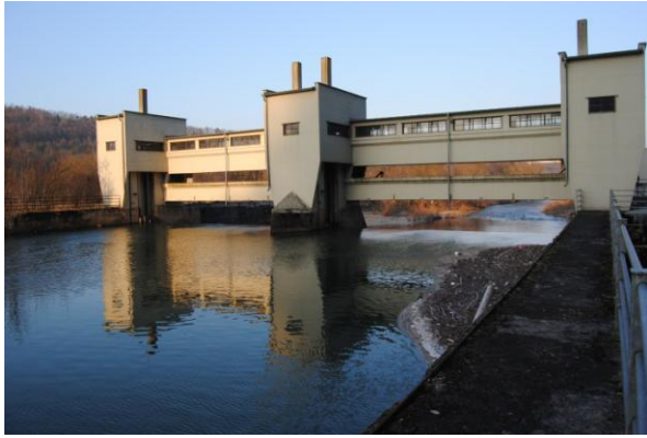
Abbildung. 11.3 und 11.4: Wehranlage mit 2-feldrigem Schützenwehr
