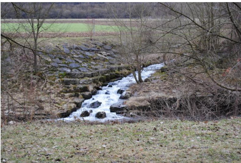
Abbildung 10.5: Fischpass an der Wehranlage, hier die Einmündung in den Neckar
