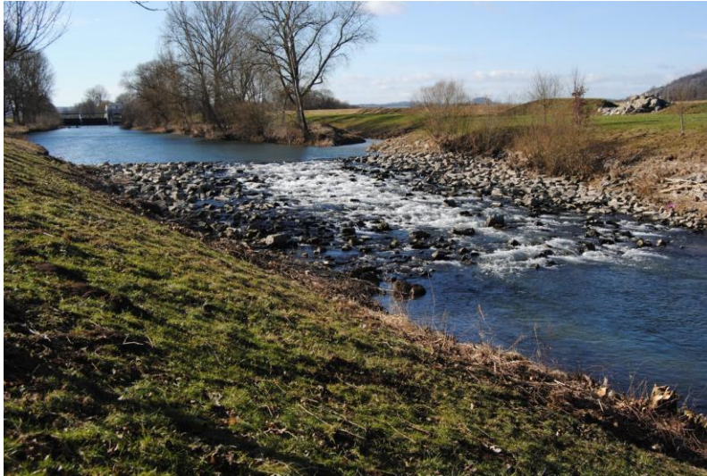
Abbildung 8.8: In Raue Rampe umgebaute Sohlschwelle im Neckar
