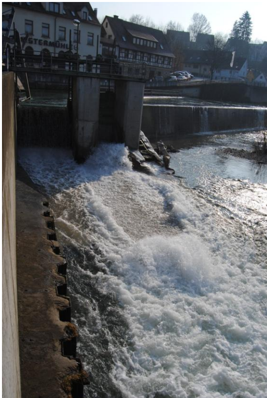
Abbildung 13.4: Überlauf mit Regelungswerk
