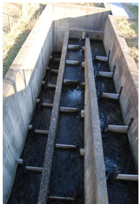
Abbildung 6.4: Vertical-Slot-Pass im Bereich nach dem Wehr
